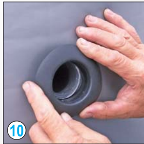
10 Manschette aufsetzen und eindrücken
